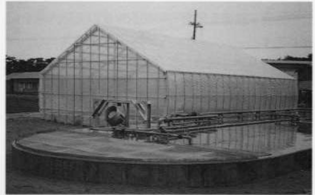
回分式活性汚泥法の曝気槽と汚泥ろ床ハウス(中条町T農場)
